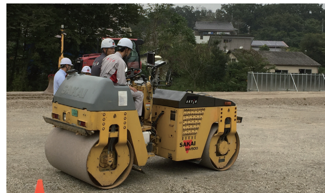
ICT建機の操作モニター
